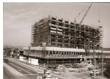
〔資料番号:写真 46033〕 建設中の東区役所
