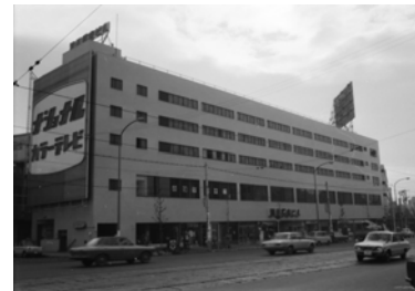
清川名店ビル外観(S44撮影) (写真資料:44125)
